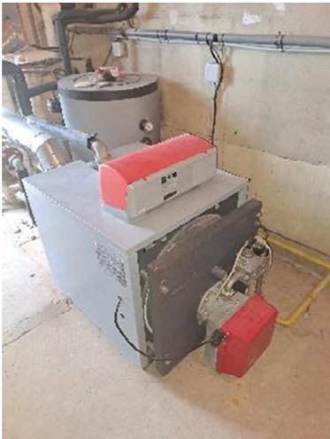
La production de chaleur est assurée par une chaudière de marque UNICAL de 2007, type MD 76. Elle est équipée d'un brûleur de marque RBL, d'une puissance de 91 kW. Cette chaudière assure le chauffage des deux bâtiments, et également la production d'ECS de la Salle Rambaud.
