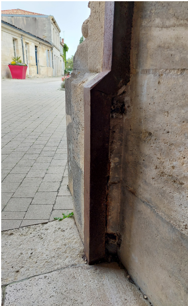
Corrosion fer d'angle - Pierres éclatées 3
