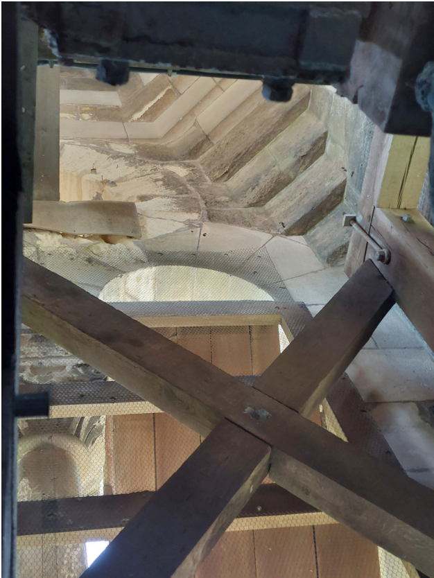
Elévation Sud - Pierres de l'oculus alvéolisées 3
