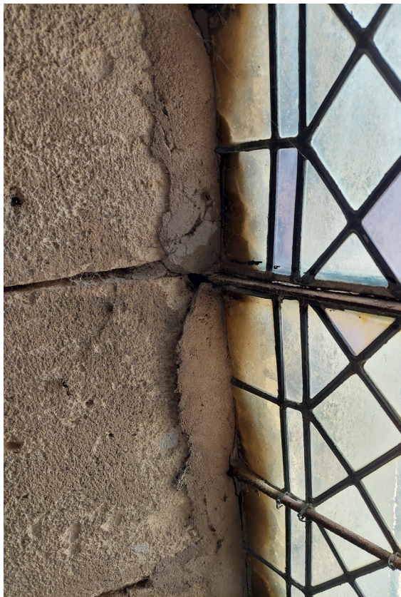
Scellements du vitrail au ciment 4
