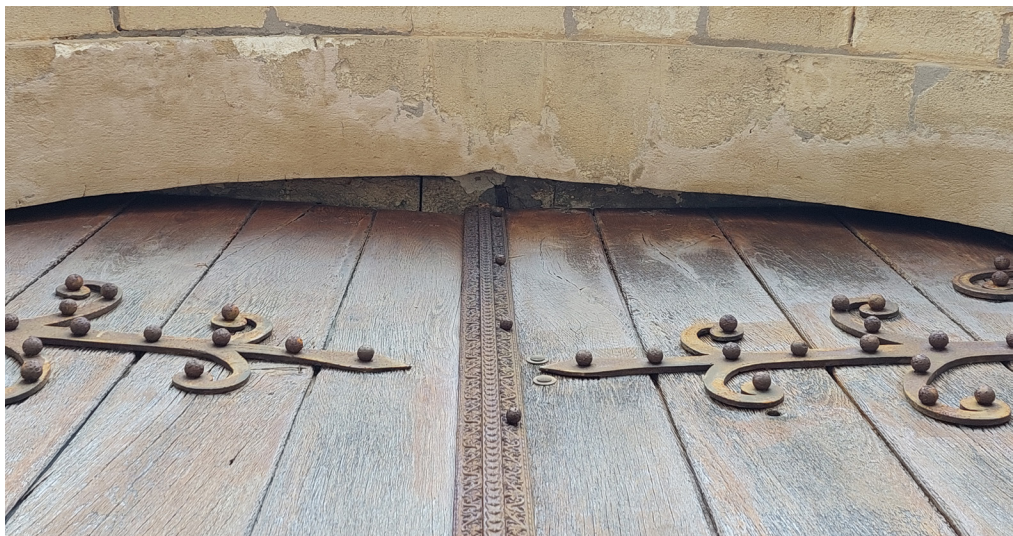
Vantaux déformés - Joints ouverts - Perte de teinte 3
