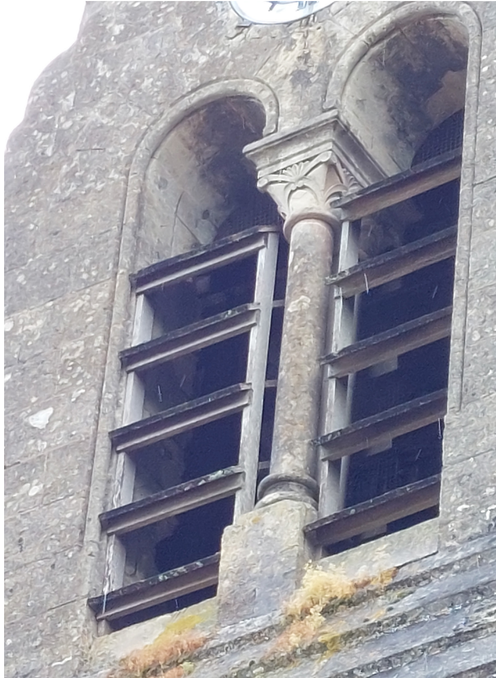
Végétation - Abat-sons très abîmés - Arrière de colonnette alvéolisé 1
