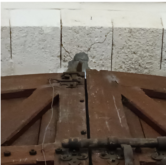
Vantaux déformés - scellement au ciment 5
