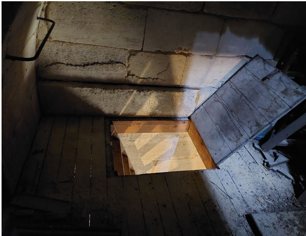
Pierres alvéolisées et fissurées 1
