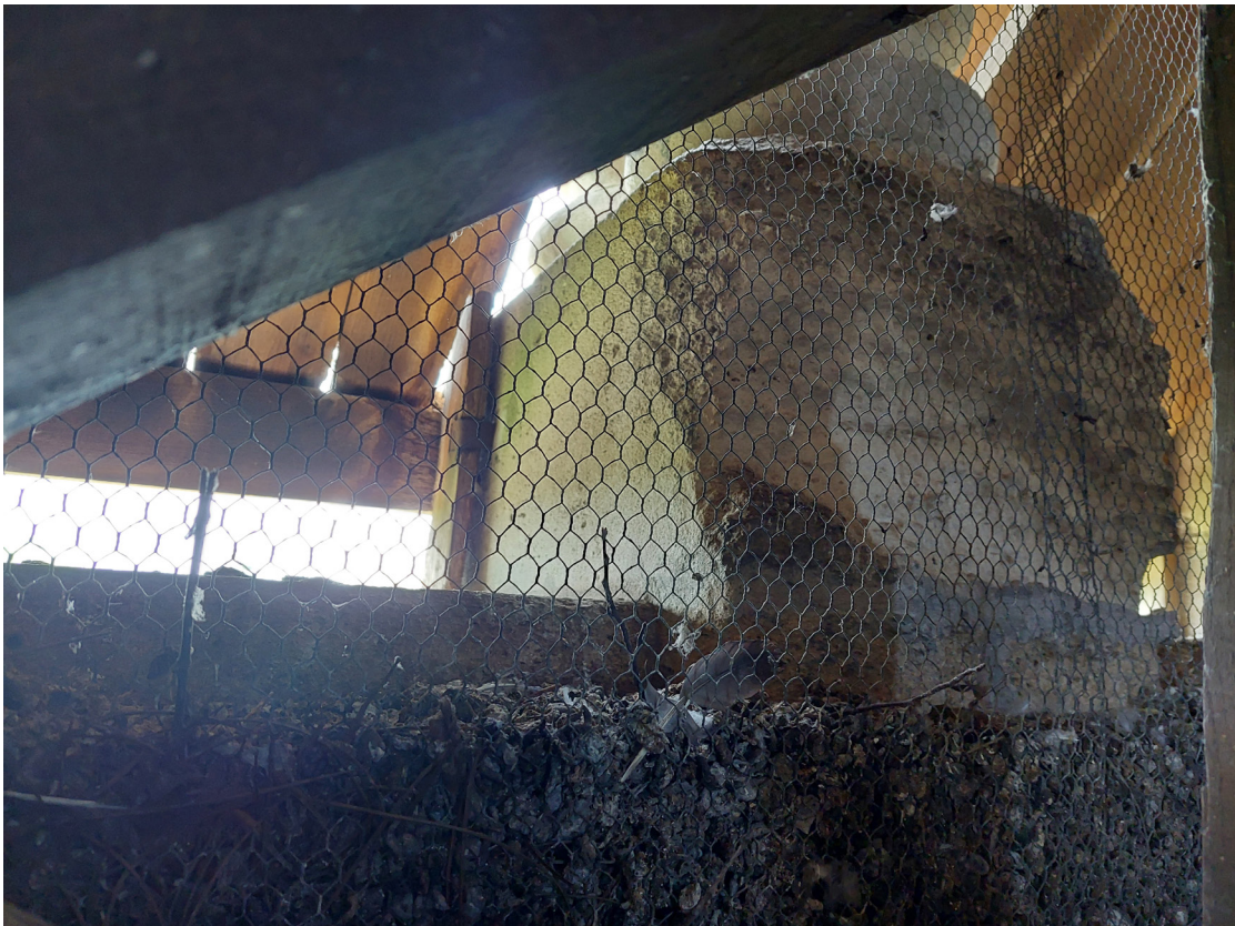
Elévation Sud - Base de colonnette alvéolisée 4
