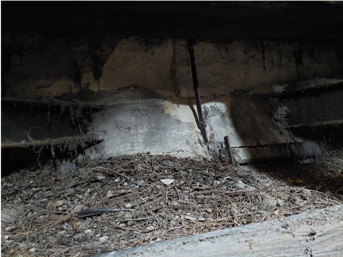
Elévation Nord - Pierres très dégradées et éclatées par les fers 2
