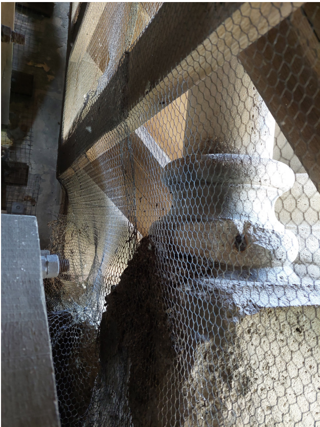
Elévation Nord - Pierres alvéolisées 5
