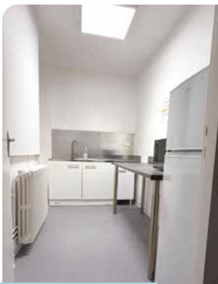
Rénovation de la cuisine et des sanitaires
