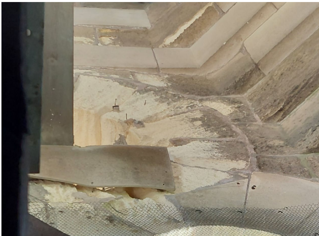
Élévation Sud : alvéolisation importante des pierres de l'oculus et des pierres supérieures de la flèche
