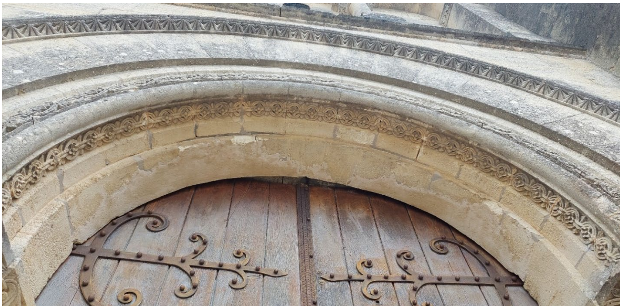
Nombreuses reprises et petits manques sur l'intrados sculpté de la voussure.
