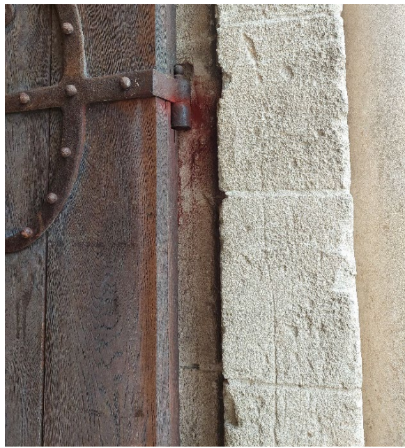
Joints à la chaux en intrados du portail Nord
