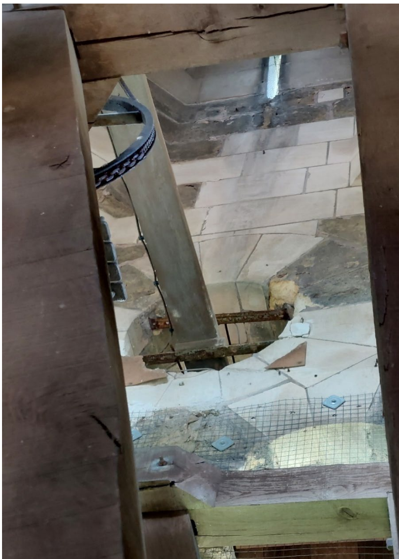
Élévation Ouest : infiltrations d'eau par les baies des clochetons, éclatement de la pierre à cause des fers corrodés, alvéolisation
