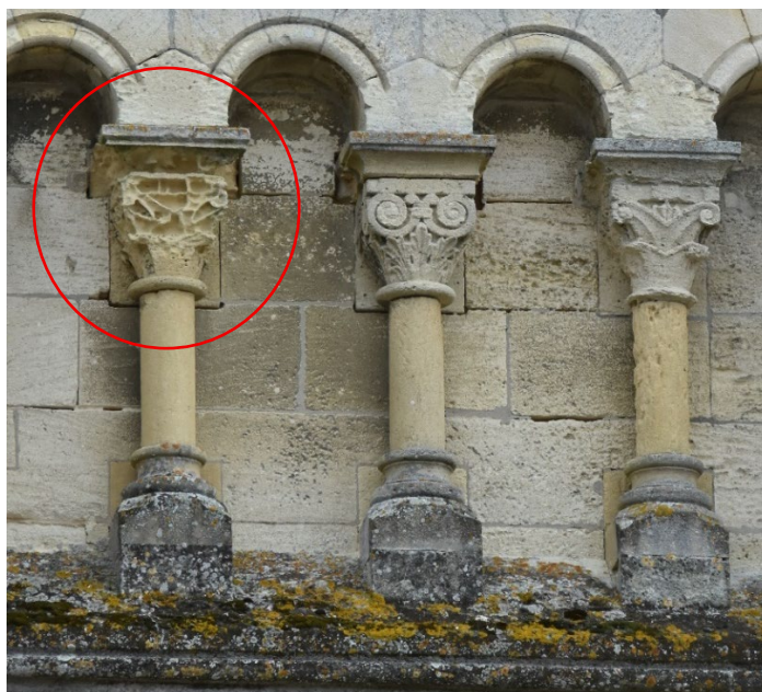
Façade Nord : colonnette alvéolisée et chapiteau fortement dégradé
