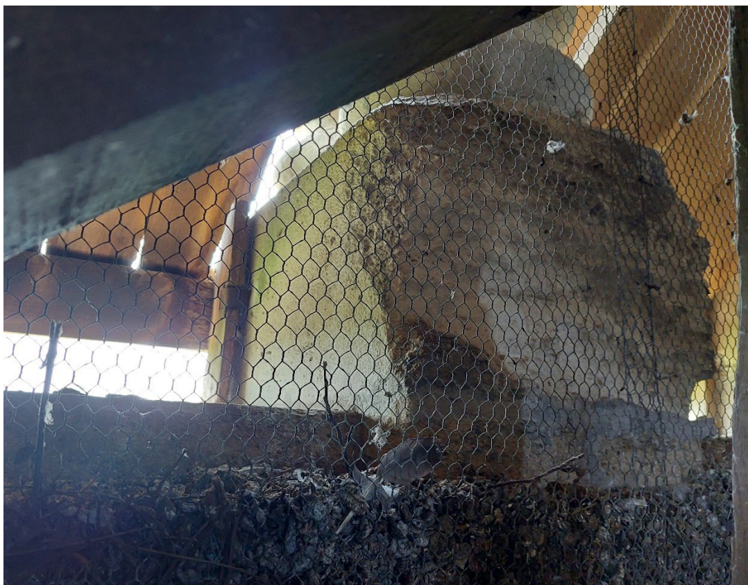
Élévation Sud : alvéolisation importante de la base des colonnettes
