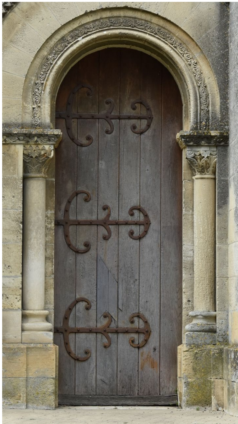
Portail Nord – Un vantail : fermeture par loquet, bon état général
