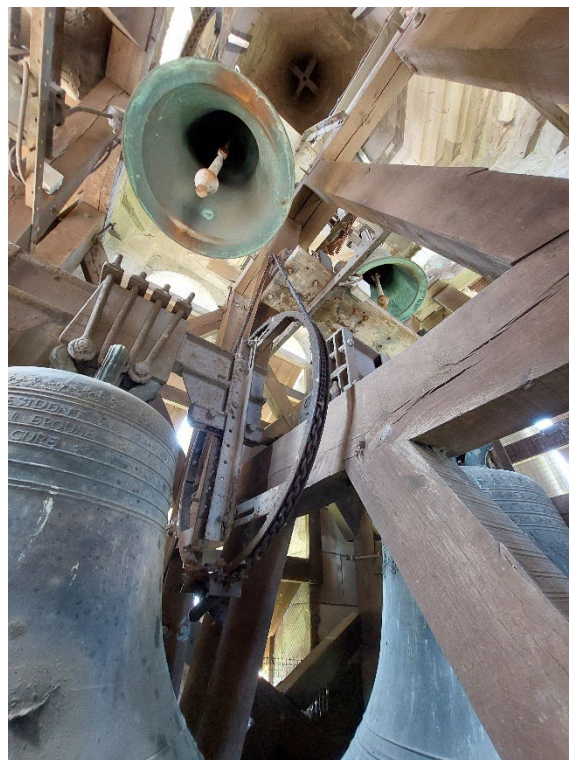
Intérieur du clocher – Détails du beffroi en bois, des cloches et de leurs mécanismes
