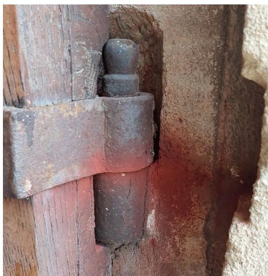
Portail Sud - État sanitaire moyen. Serrure en applique. Visserie moderne à changer. Joint en demi-rond métallique.
