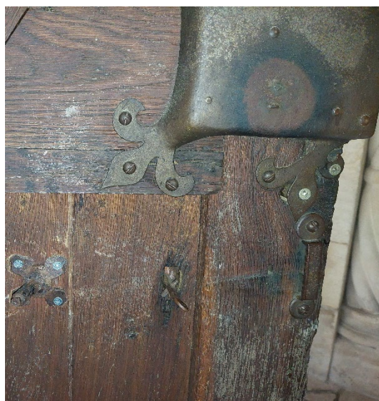
Portail Sud - État sanitaire moyen. Serrure en applique. Visserie moderne à changer. Joint en demi-rond métallique.
