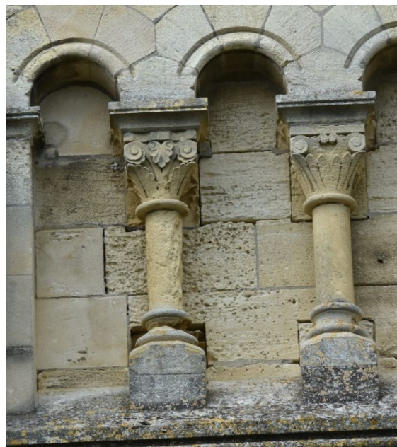
Façade Sud : colonnette et base alvéolisée et parement des arcades
