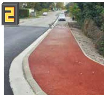
**2 Route Bleue** : l'extension du trottoir jusqu'à la gendarmerie est en cours, ainsi que la création de places de stationnement et la plantation d'arbres qui feront l'objet d'une expérimentation dite « arbre de pluie » où l'arrosage est assuré par les eaux pluviales issues de la chaussée et du trottoir.
