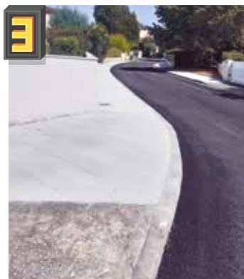
**3 Pelouses d'Ascot** : la couche de roulement a été renouvelée avec un enrobé et une première tranche de rénovation des trottoirs en béton a été effectuée.
